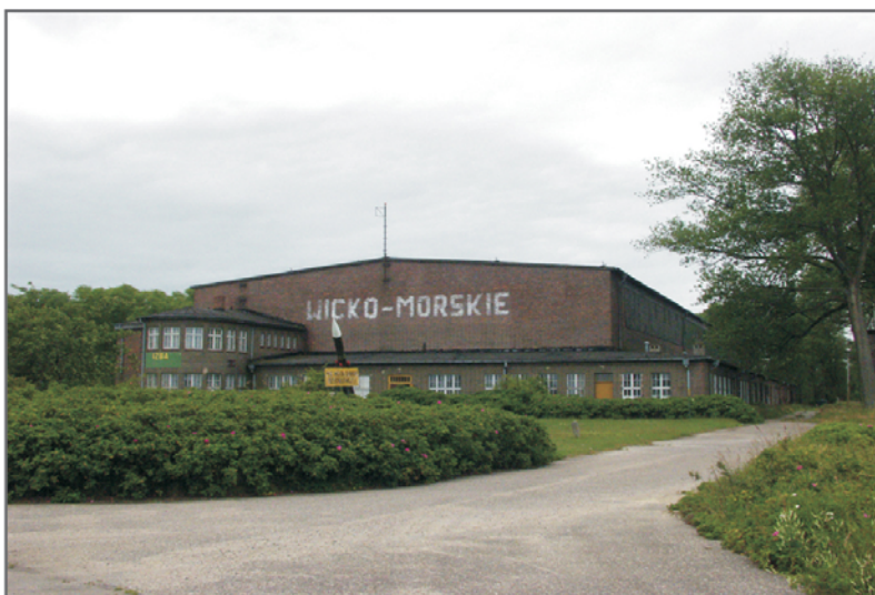
B. Widok hangaru od strony wschodniej. Fot. W. Rączkowski, 14.07.2004
